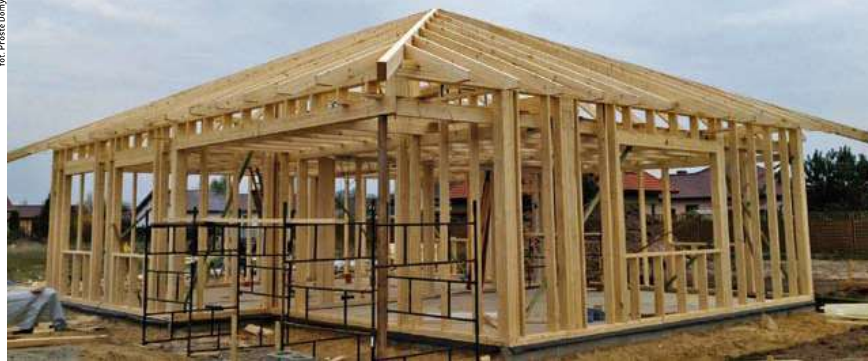
W tydzień stawiana jest drewniana konstrukcja domu, przywożona w formie ścian zbitych w tartaku.
